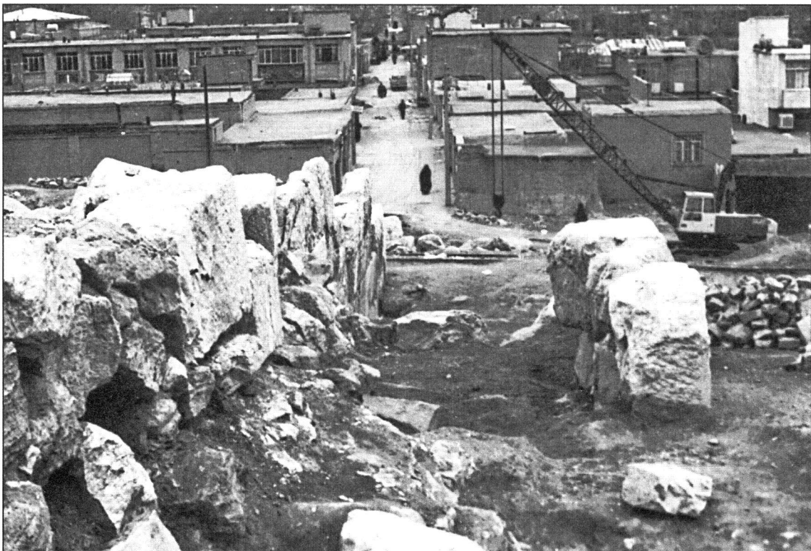
(تصویر - ۱۳): فضای خالی پلکان شمالی تختگاه شرقی، پیش از اجرای طرح باز سازی. دید روبه شمال. (در بالای تصویر گذری در راستای پلکان شمالی به چشم می خورد که به بنای مسجد جامع در بالای منتهی می گردد.)
